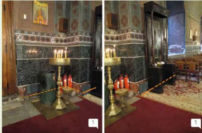
Έργο Δάκτυο Κλιματισμού Ιερού Καθεδρικού Ναού Αγίας Σοφίας Θεσσαλονίκης. Φος 2021 ©. Θεοδοσοπούλης Μην., Μηχανικός
