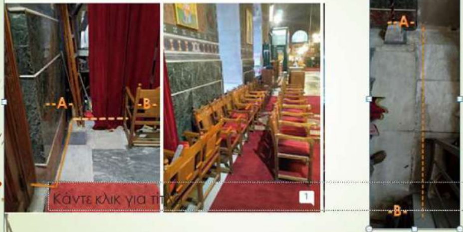
Έργο Δίκτυο Κλιματισμού Ιερού Καθεδρικού Ναού Αγίας Σοφίας Θεσσαλονίκης. Ώς 2021 Θ. Θεοδοσοπούλης Μητ. Μηχανικός
